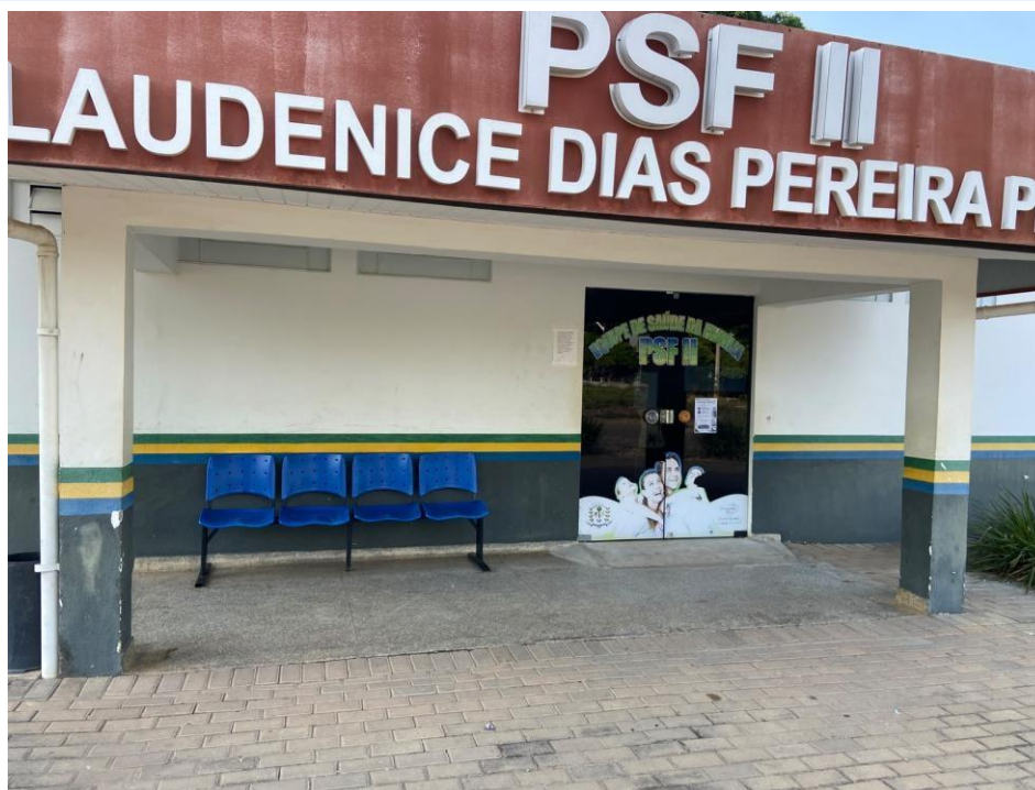
Foto 07 – 1.1. Hall de Entrada
