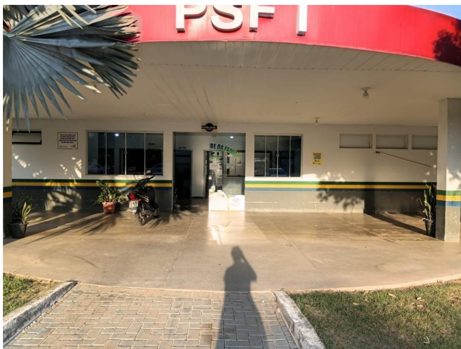
Foto 06 – 1.1. Hall de Entrada
