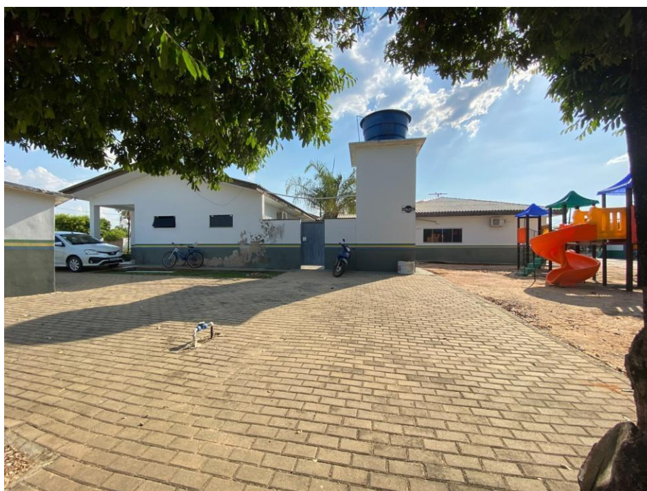
Foto 02 – Fachada Lateral Direita
