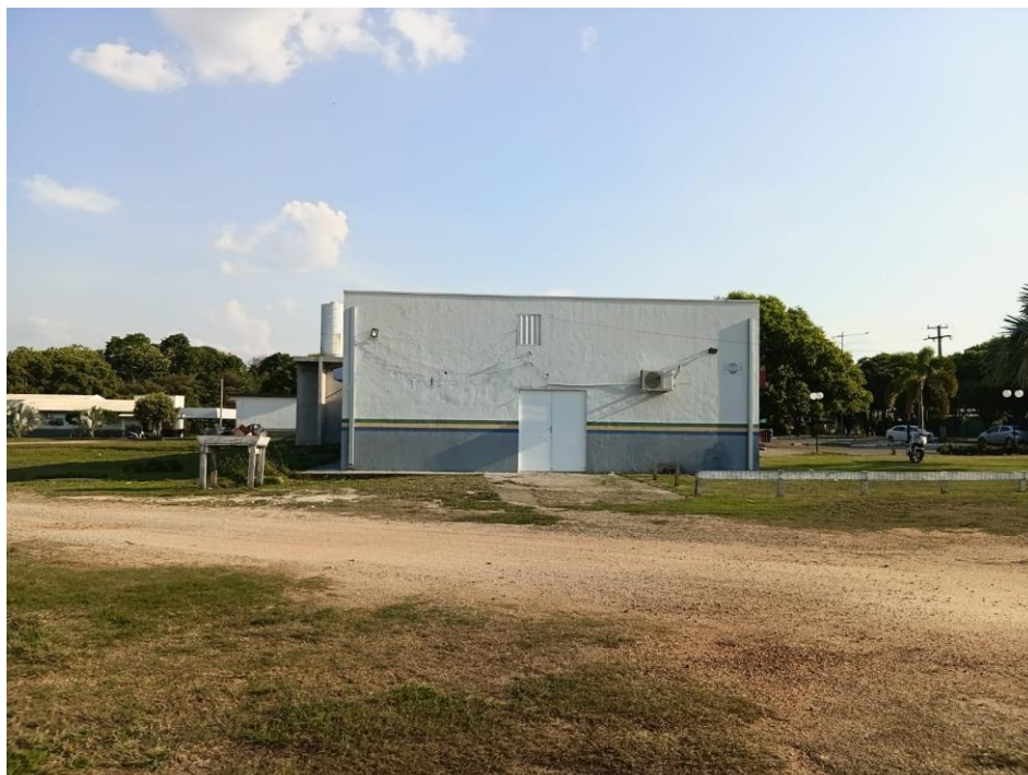
Foto 05 – Fachada Lateral Esquerda
