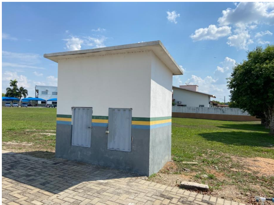
Foto 34 – 6.3. Abrigo Resíduos Comum
