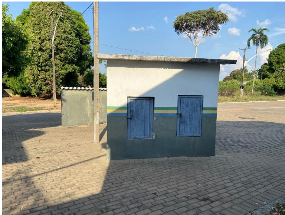
Foto 47 – 6.2. e 6.3. Abrigo Resíduos 1 e 2
