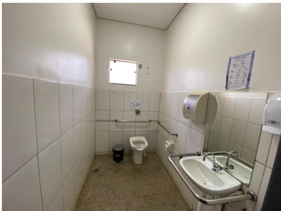
Foto 07 – 1.3. Banheiro P.C.D. Masc.
