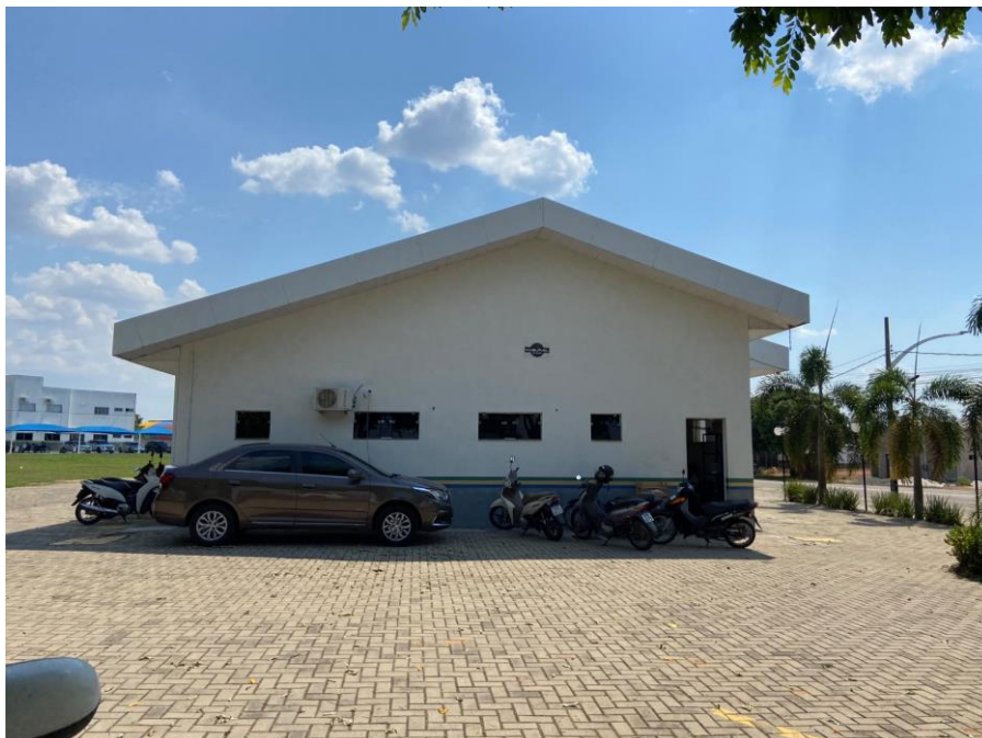
Foto 04 – Fachada Lateral Esquerda
