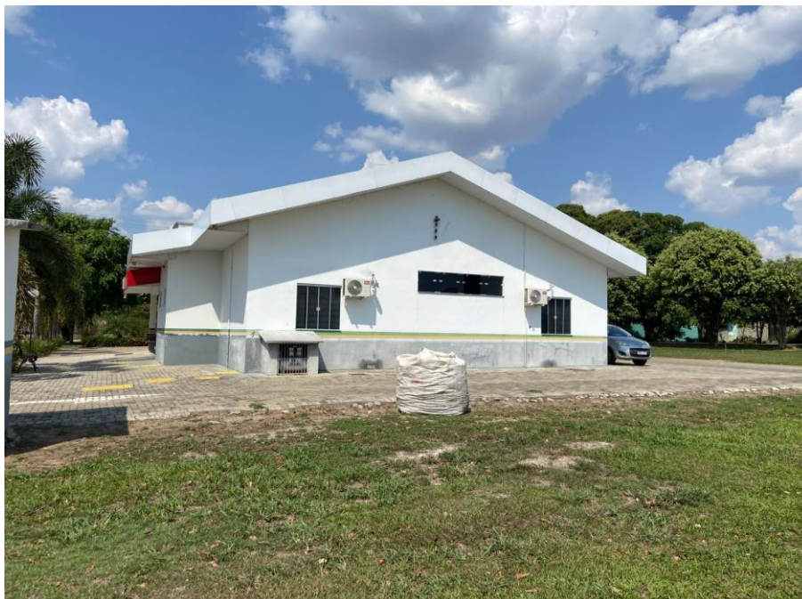
Foto 02 – Fachada Lateral Direita
