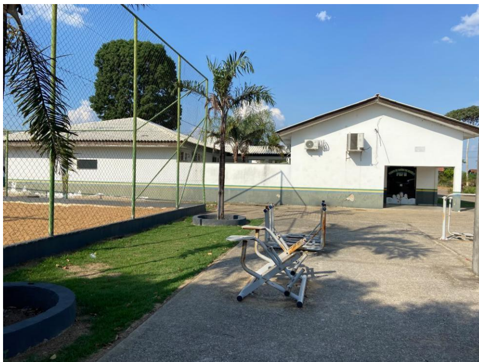
Foto 04 – Fachada Lateral Esquerda
