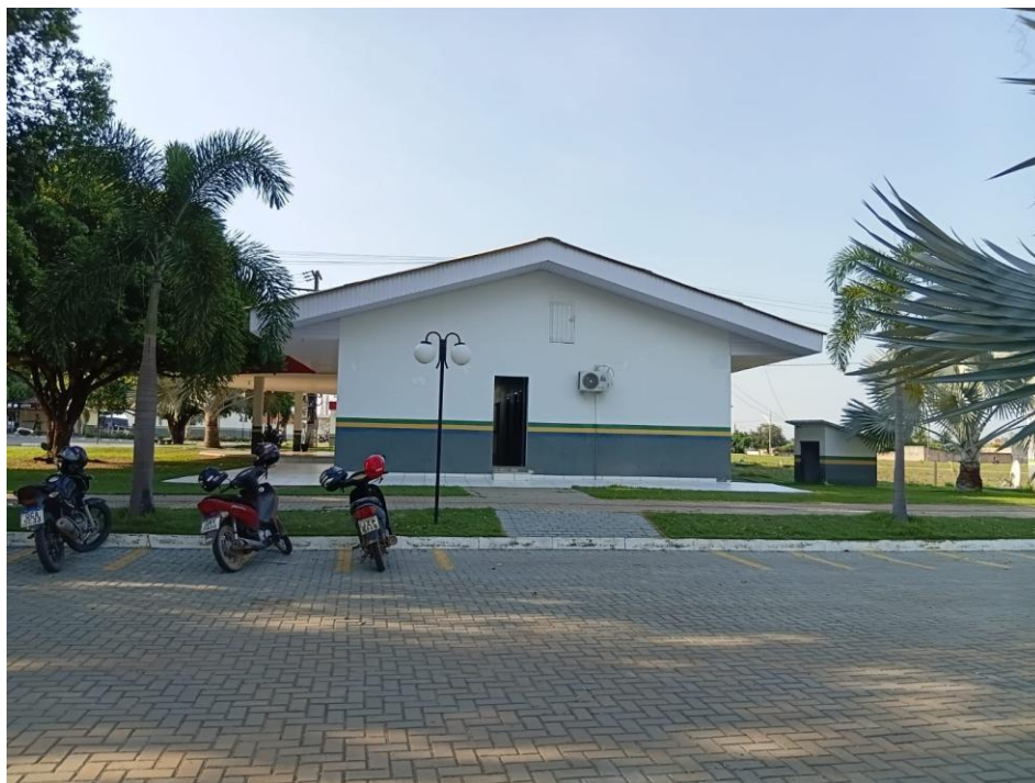
Foto 03 – Fachada Lateral Direita
