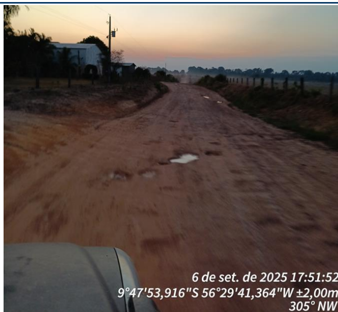
Foto 08: Situação do trecho final da estrada que sofrerá intervenção
