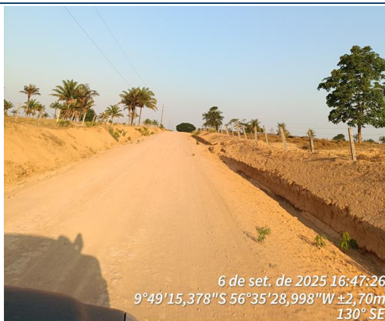
Foto 03: Situação do trecho meio da estrada que sofrerá intervenção
