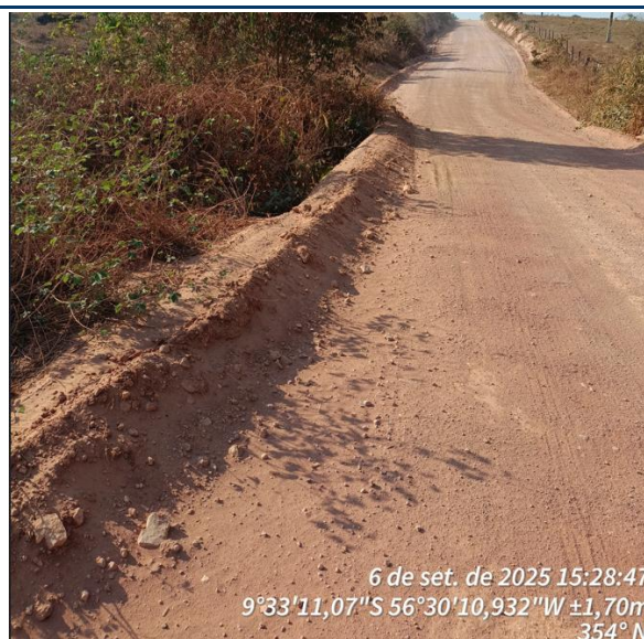
Foto 10: Situação do trecho meio da estrada que sofrerá intervenção
