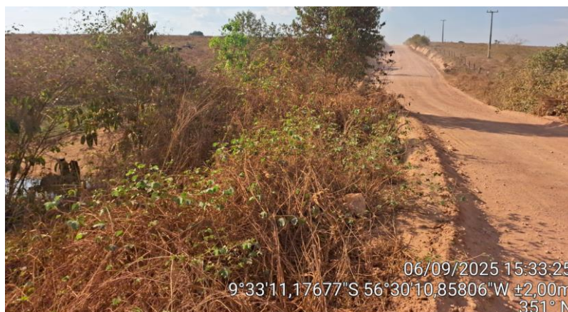
Foto 12: Situação do trecho final da estrada que sofrerá intervenção
