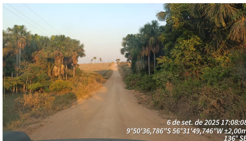
Foto 04: Situação do trecho final da estrada que sofrerá intervenção
