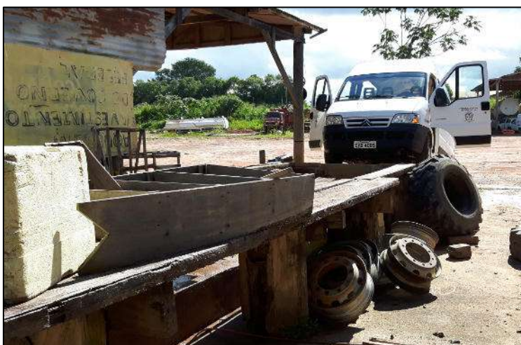
Foto 65 - Lavador - Rampa em madeira e danificada.
