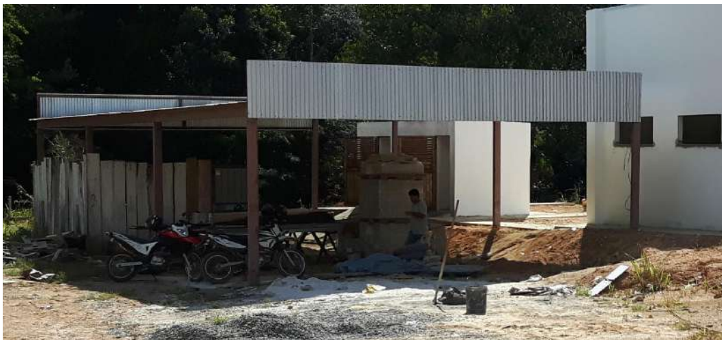
Foto 25 – Estrutura metálica destinada a Ambulâncias da Saúde localizada no hospital municipal “Hospital em processo de ampliação”.
