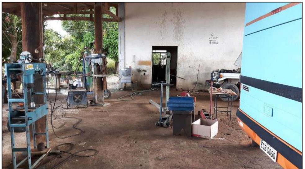
Foto 43 – A oficina não possui piso adequado e não possui equipamentos em condições adequadas de uso.
