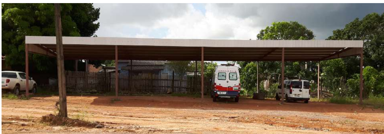
Foto 24 – Garagem com estrutura metálica destinada a ET da Saúde com lugar para 08 ET.
