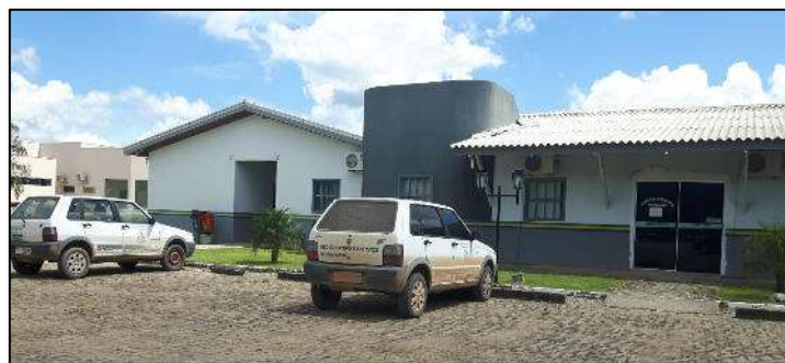
Foto 22 – Estacionamento da Sede da prefeitura, onde ET ficam estacionados sem cobertura adequada em finais de semana. Com vigia somente no período noturno. Não possui monitoramento por câmeras.
