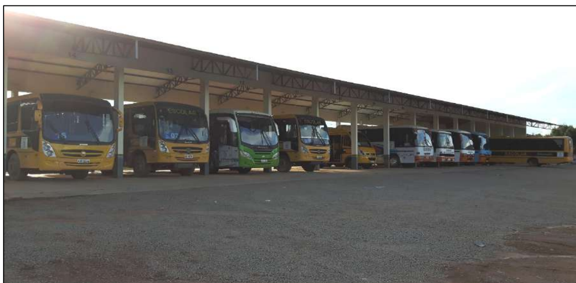
Foto 23 – Estrutura ampla e adequada, garagem em alvenaria com estrutura metálica coberta com espaço para 15 ET da Educação.
